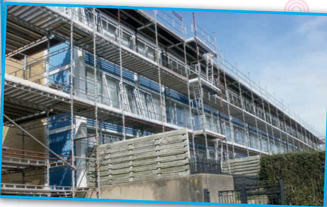
Den første blok har fået ny facade mod havesiden. Her er håndværkerne godt i gang på øverste etage.
