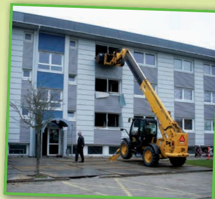
Renoveringen på Stengårdsvej er i gang
